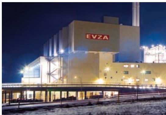
Die EVZA in Staßfurt ist eine der modernsten Anlagen in Deutschland.
