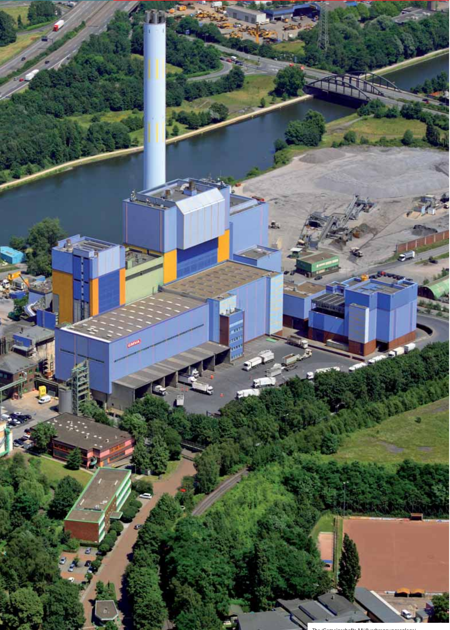
The 'Gemeinschafts-Müllverbrennungsanlage' (waste incineration plant) in Oberhausen
