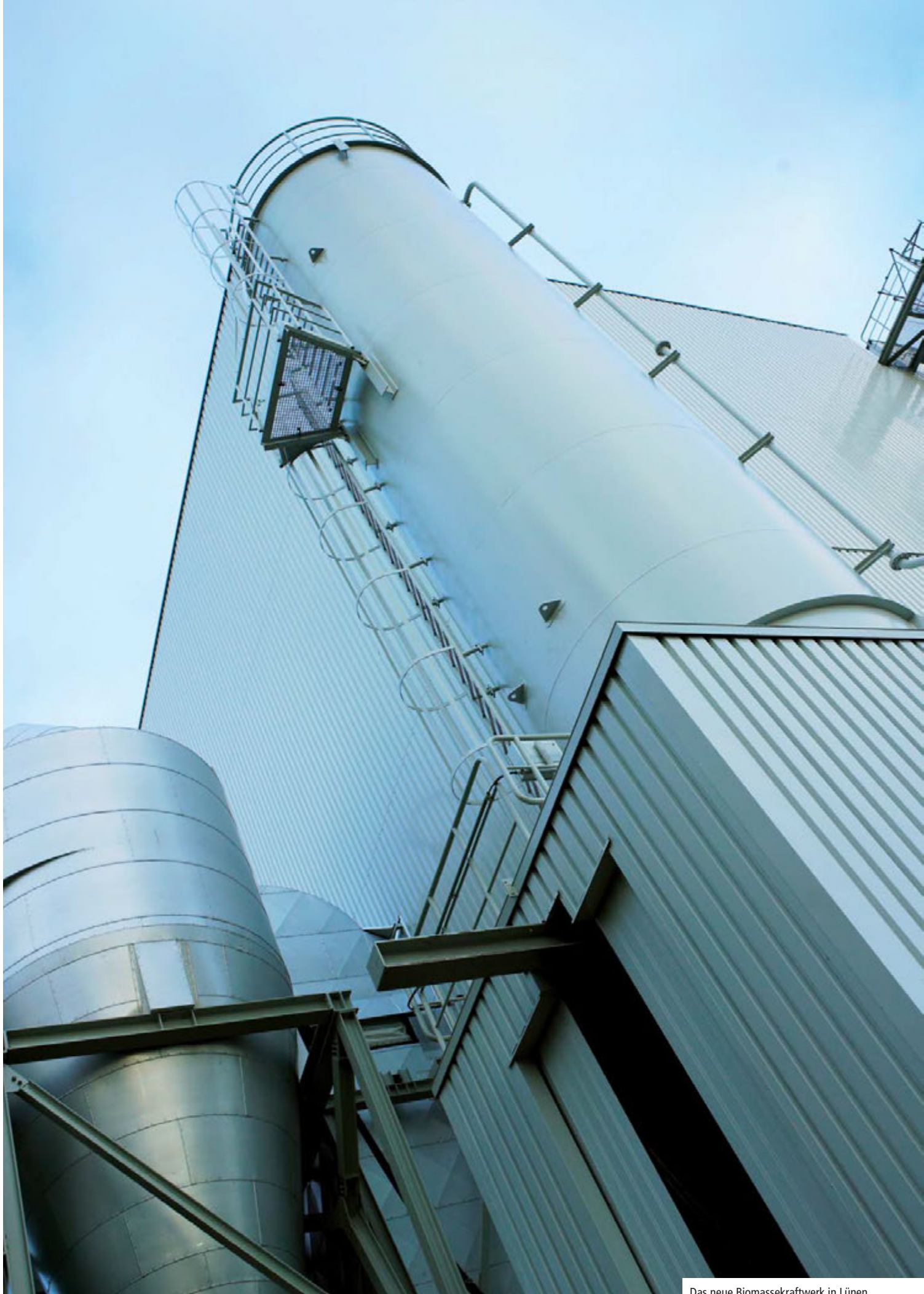
Das neue Biomassekraftwerk in Lünen
