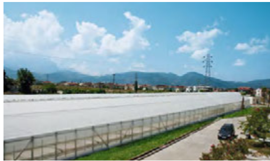
In Fethiye können mittels der natürlichen Ressource des Sonnenlichts jährlich insgesamt 12.000 Tonnen Klärschlamm getrocknet werden
