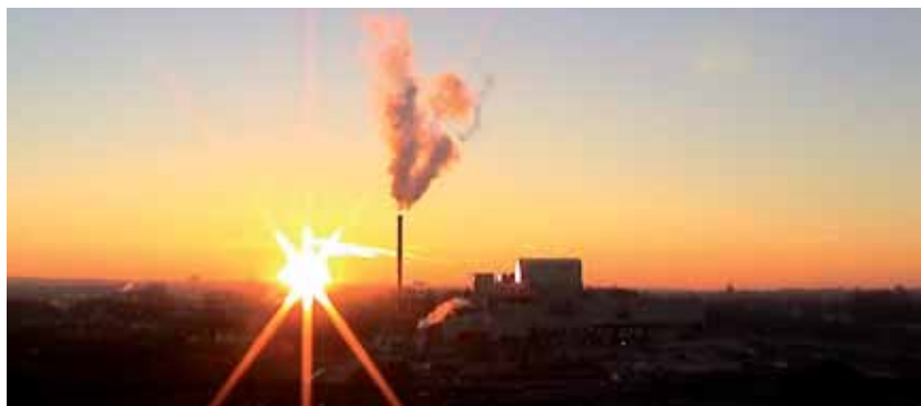
W Weurt ARN eksploatuje instalację na paliwo wysokokaloryczne.
