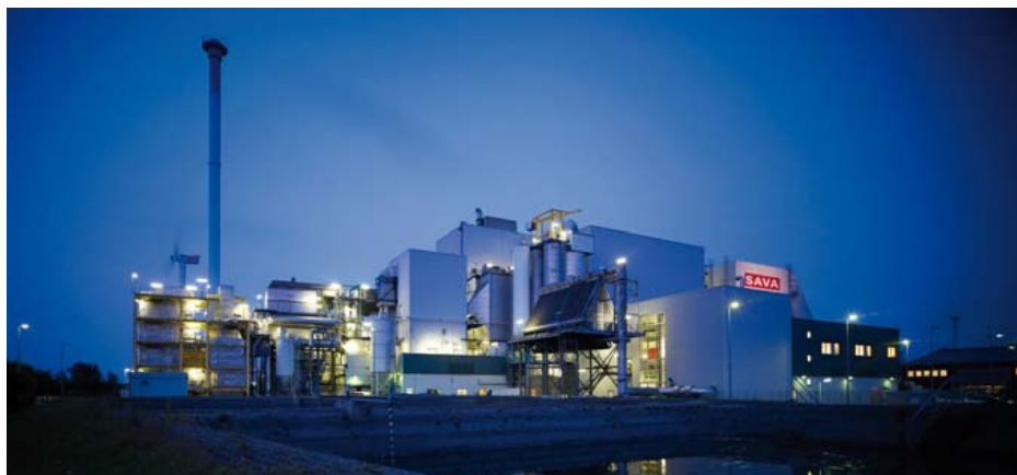
Podczas spalania odpadów można zrezygnować z paliw kopalnych. SAVA dostarcza do publicznej sieci 5680 MWh energii elektrycznej i przyczynia się do zmiany polityki energetycznej
