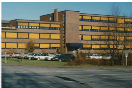
◀ 1987 rozbudowa centrali w Selm
