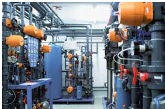
Jako kontraktor REMONDIS Aqua było odpowiedzialne za rozbudowę instalacji wodno-kanalizacyjnej w fabryce WILD Valencia SA i przejęło eksploatację tejże instalacji. Teraz w ramach oczyszczania ścieków operator pozyskuje dodatkowo biogaz, który wykorzystuje się do wytwarzania pary, potrzebnej w produkcji właściwej.
