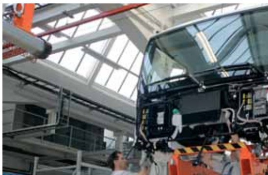
Gwarancja bezpieczeństwa procesów i eksploatacji: MAN Nutzfahrzeuge zleciło REMONDIS modernizację, rozbudowę i eksploatację przykładowej instalacji do oczyszczania ścieków przemysłowych.
