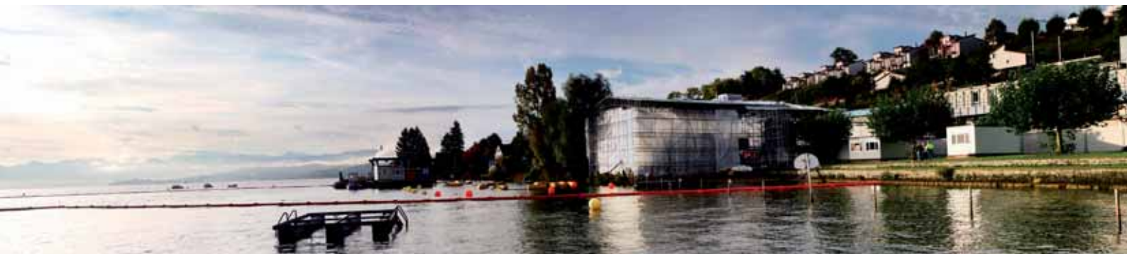
Instalacja do przetwarzania osadów na brzegu jeziora. Podczas rekultywacji Zürichsee wykorzystano cały wachlarz usług będących do dyspozycji grupy REMEX w Szwajcarii i w Niemczech.
